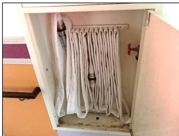
圖 3-40 平時即將水帶與瞄子接妥並掛好，緊急時即可減少許多步驟
