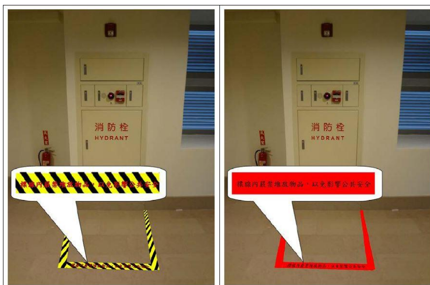
圖 3-41 室內消防栓前應劃設淨空範圍
