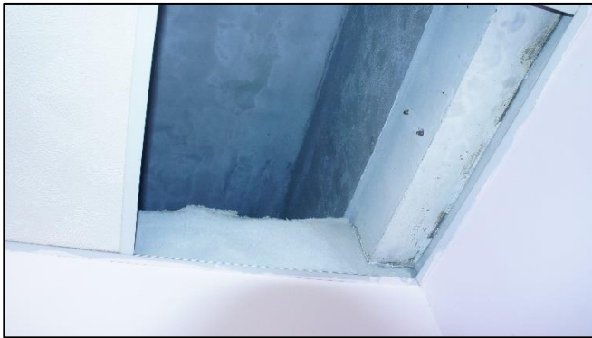
圖 3-4 高雄市某護理之家防火門上方隔間牆未頂實上方樓地板，使火煙有機會延燒與竄流之鄰接區劃
