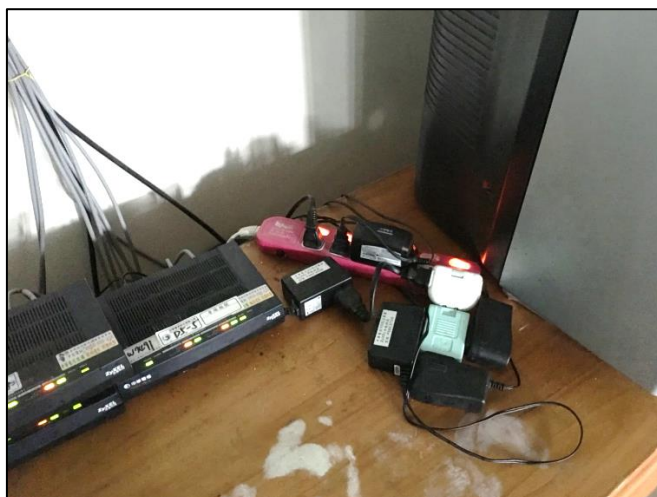
圖 4-3 延長線插滿插座，易導致過載引發火災
