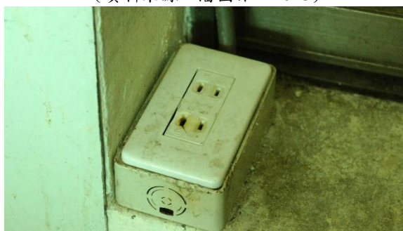
圖 4-5 汙損甚至因長期使用燒焦的插座，應立即汰換
