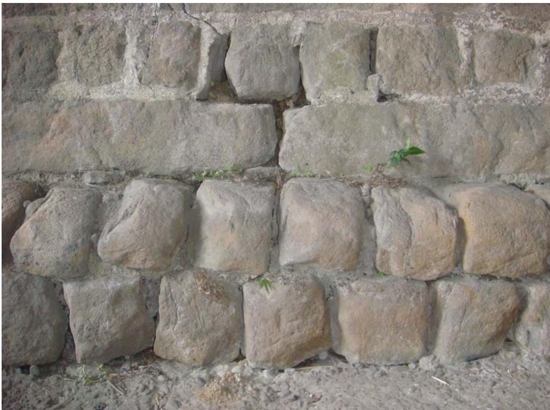
圖3-16 清代橋基及橋台之整層粗石砌法
