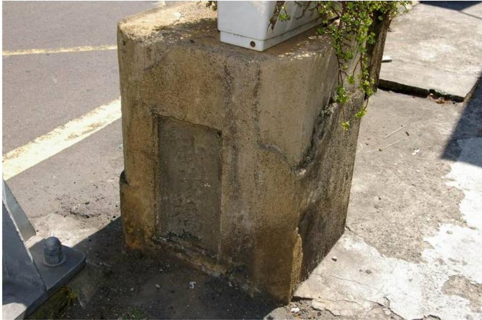
圖 2-63 日治時期「武陵橋」之欄杆橋名柱牌額題字，該橋為 RCT 桁橋構造，目前僅存北側欄杆，本研究拍攝。
