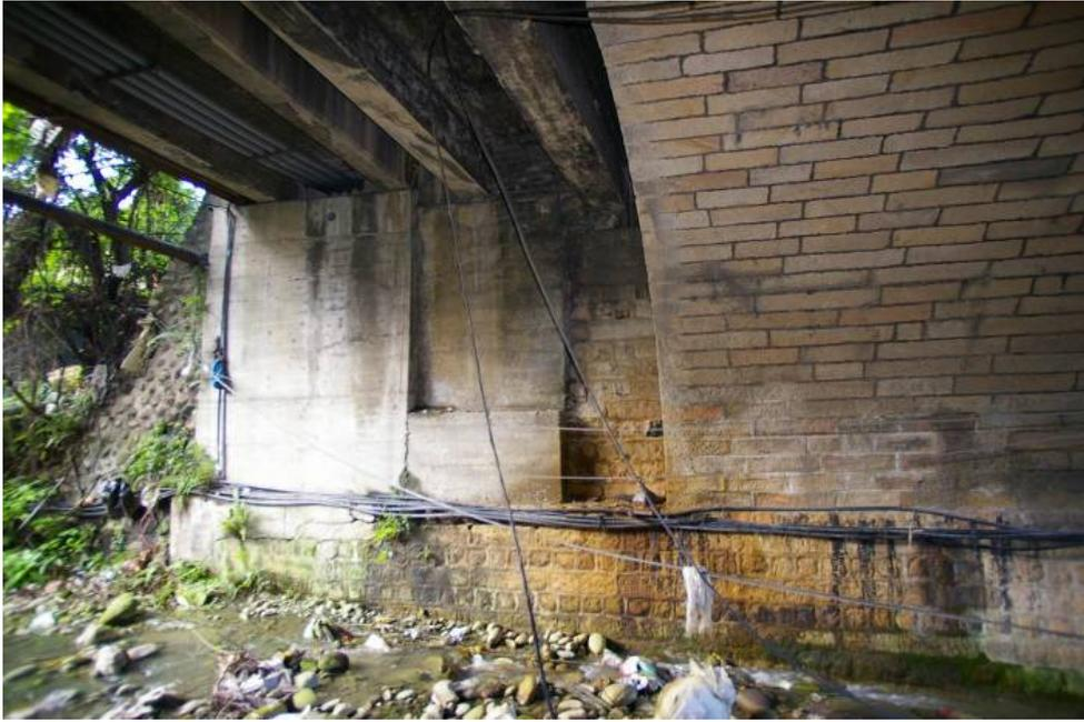
圖 2-92 「大坑溪橋」拓寬後之東側橋底現況，由南下車道底部橋台處可清楚看到歷次修建之過程，本研究拍攝。
