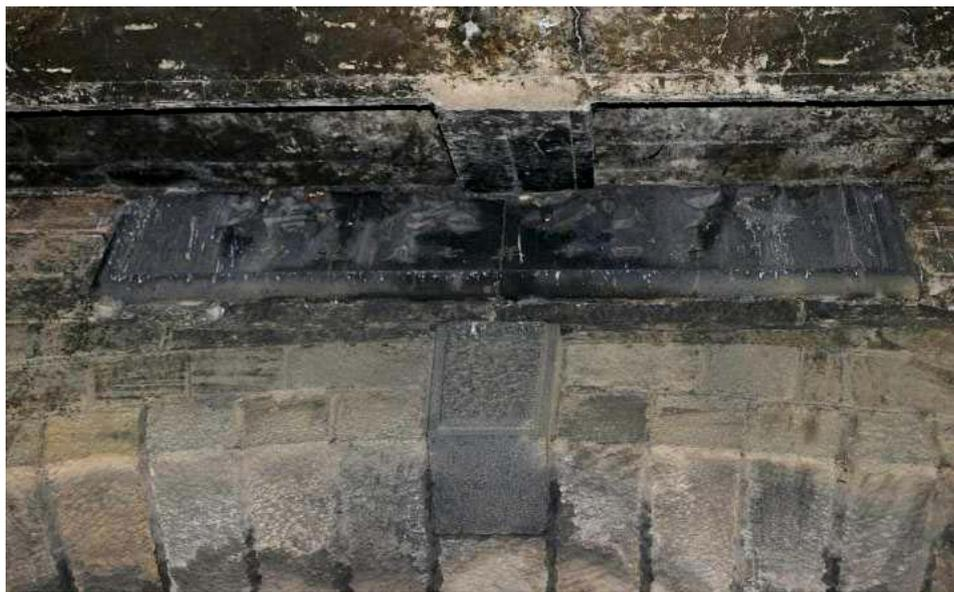
圖 2-42 日治時期「大坑溪橋」牌額，其材質為觀音山石，而清末「九芎頭坑橋」於 1907 年（明治 40 年）7 月修築竣工改稱「大坑溪橋」，本研究拍攝。
