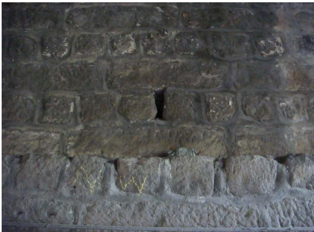
圖3-24 第二尖山橋橋台之孔洞外觀
