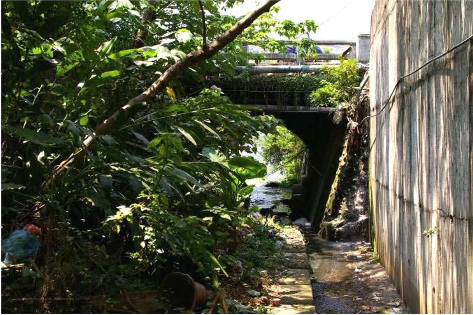
圖 2-96 「第二尖山橋」拓寬後之北側橋底外觀，此橋底部之石拱橋位於北上慢車道下方，本研究拍攝。
