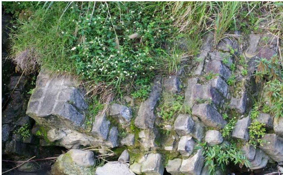
圖 2-36 清末台北至新竹段鐵路「九芎坑橋」遺址南側掉落坡坎之細部，圖中可以看到當時坡坎構築方式採「丁順砌」砌置，本研究拍攝。
