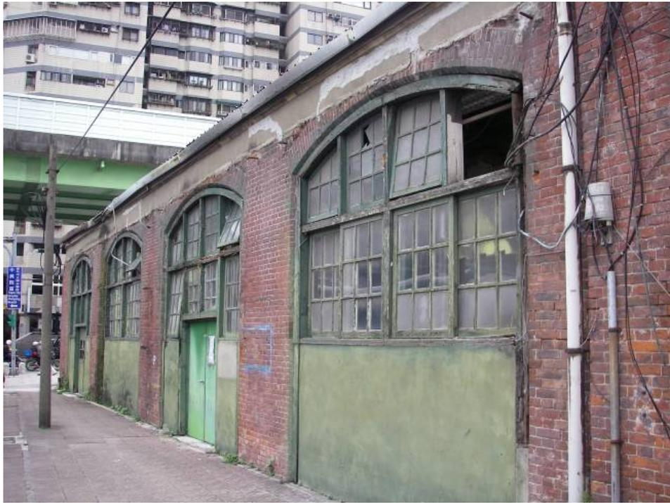
圖 2-19 鐵路局舊禮堂西側立面，圖中窗孔於日治時期時曾作為鐵道部台北工場車輛軌道使用，本研究拍攝。
