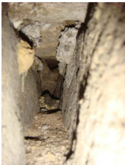
圖3-25 第二尖山橋橋台之孔洞內部
