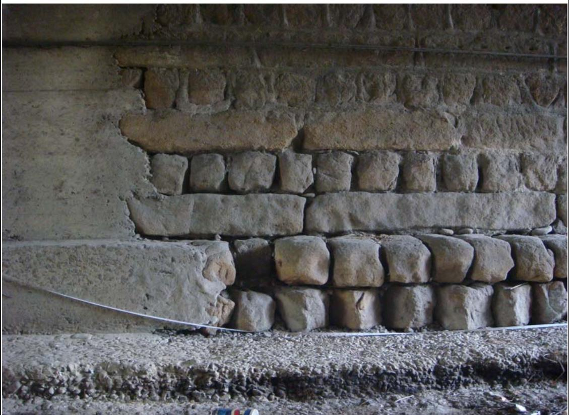
水泥砂漿、灰漿剝落
