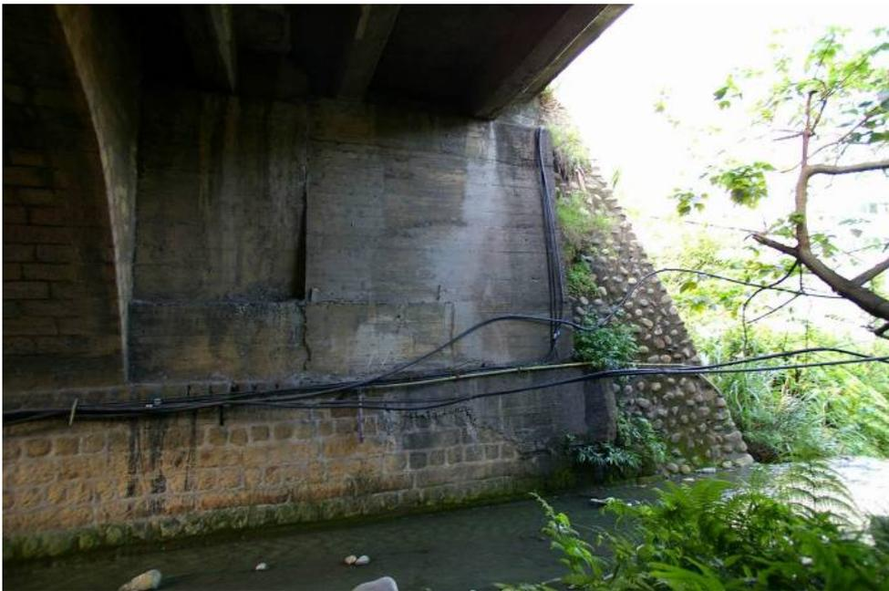
圖 2-93 「大坑溪橋」拓寬後之東側橋底現況，由北上車道底部橋台處可清楚看到歷次修建之過程，本研究拍攝。
