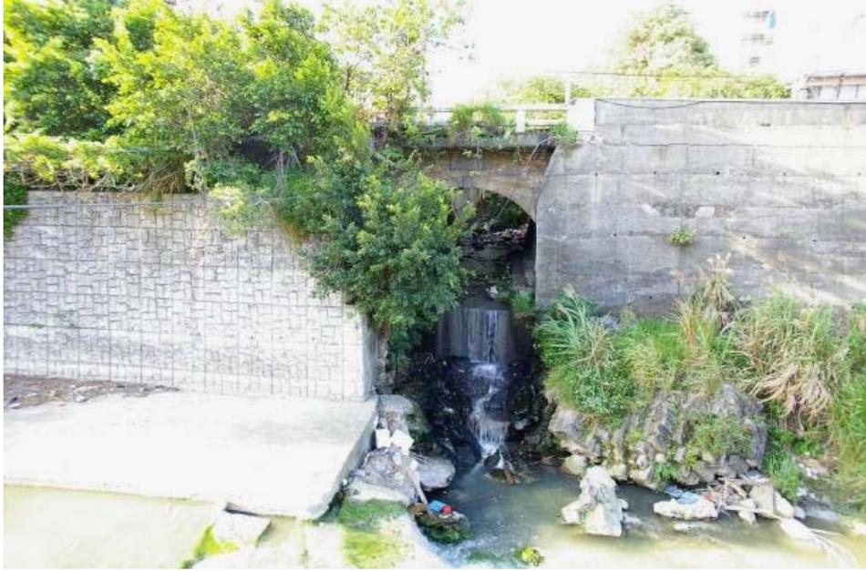
圖 2-35 清末台北至新竹段鐵路之「九芎坑橋」遺址南側，石拱橋為第二尖山橋底部構造，右下側掉落於塔寮坑溪上之石塊為原路基坡坎，本研究拍攝。
