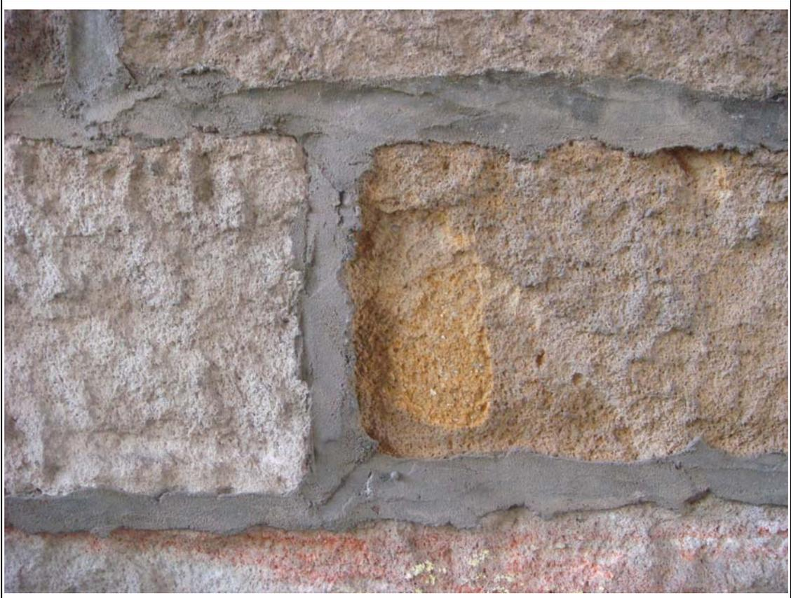
水泥砂漿填縫、塊石表層剝落
