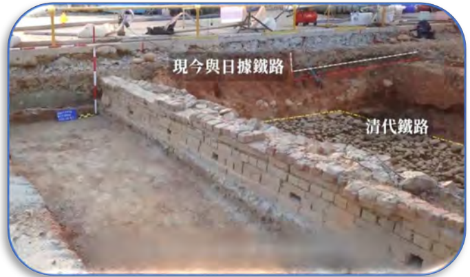
G07 站文資挖掘情形
