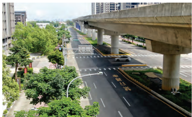
圖 4 GC01 標高架段施工照片(八德區建德路)
