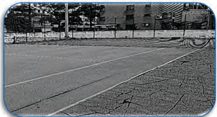
附設網球場地面鋪設龜裂
