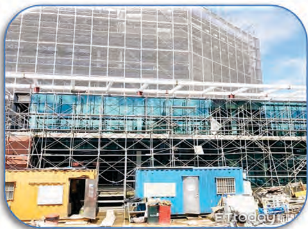
楊梅行政大樓施工現場圖
