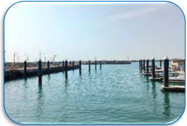
竹圍漁港浮動碼頭浮箱體吊離後遺留鋼管樁場景
