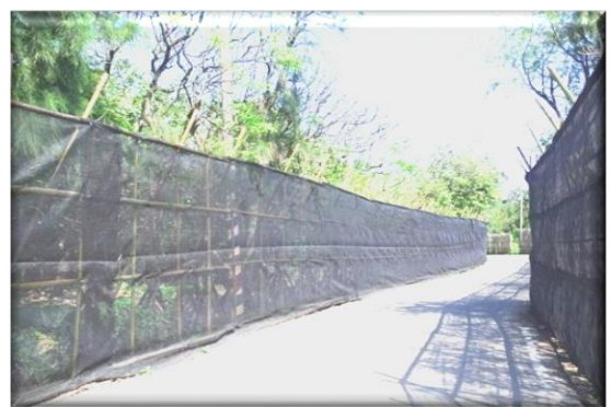
圖 4 許厝港戰備道路設置之防風圍籬
