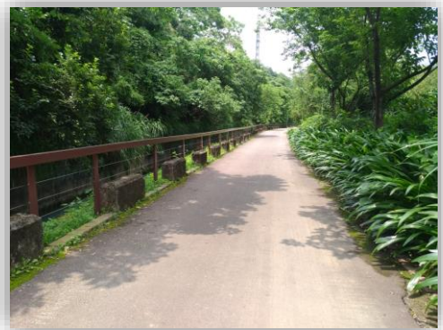
圖 4 城鎮之心工程計畫—龍潭區三坑子自行車道改善工程
