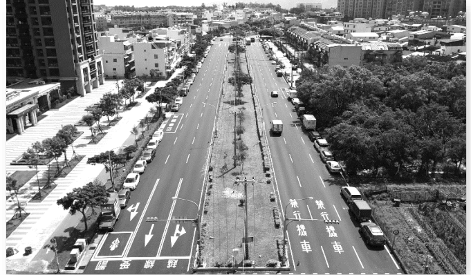
圖3 桃園市八德區豐德路鋪面工程完工使用情形
