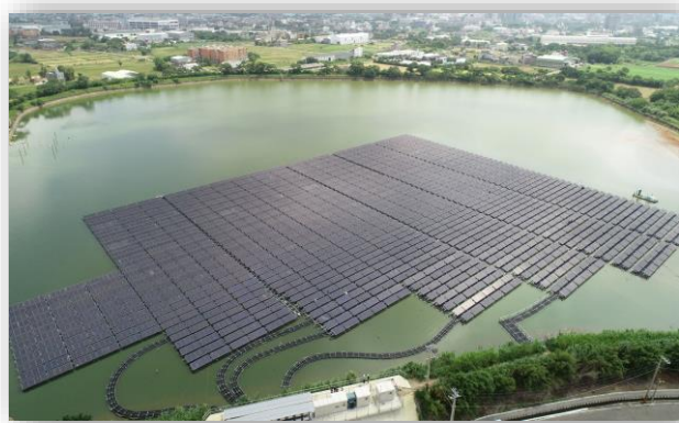
圖 2 桃園大圳 4-6 號池設置埤塘光電
