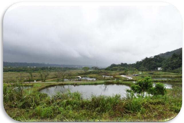
圖 2 大溪排水自然水質淨化工程埤塘溼地
