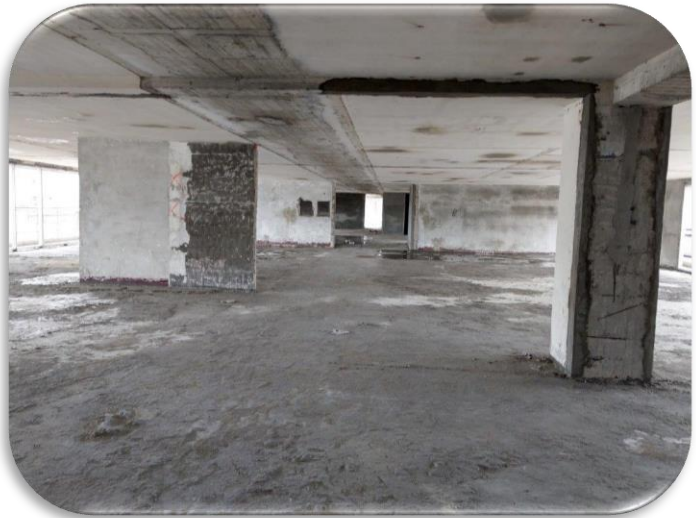
圖 1 新明市場 6、7 樓現況
