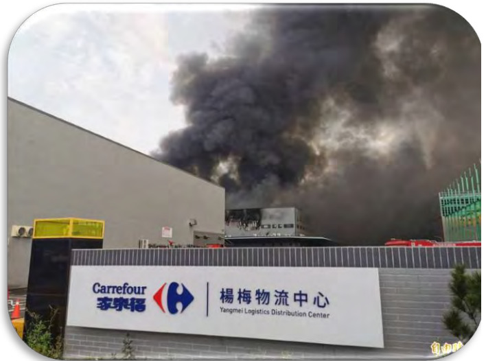
家樂福楊梅物流中心倉庫大火
