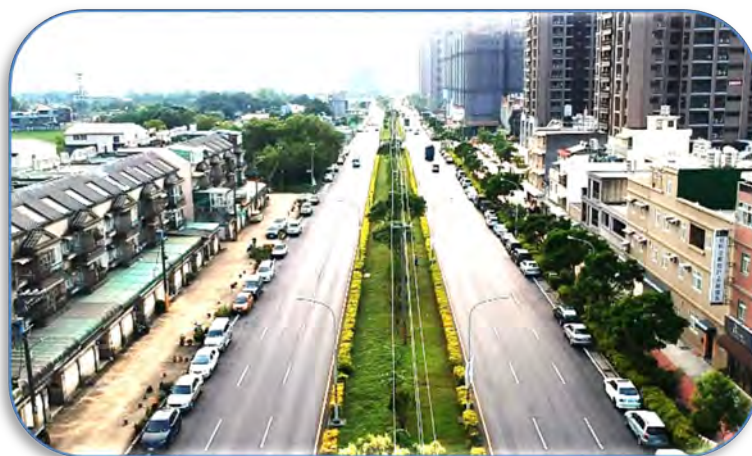
八德區豐德路氧化矽瀝青混凝土鋪面
