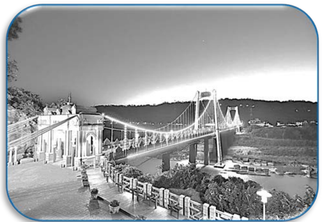
桃園市大溪區大溪橋整修完成現況
