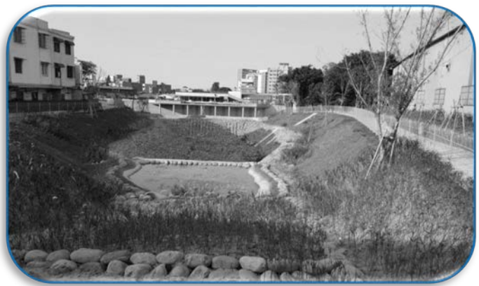
大牛欄分渠 14A 滯洪池現況
