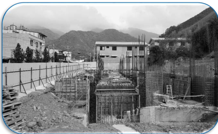
羅浮多功能辦公廳新建工程施工情形
