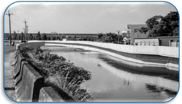
埔心溪幹線(斷面 90 至斷面 96) 呂厝橋至攔河堰左岸護岸新建應急工程
