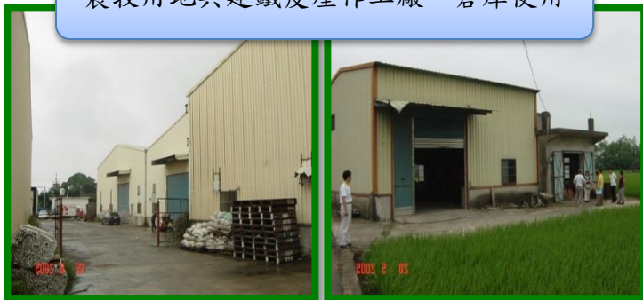
農牧用地興建鐵皮屋作工廠、倉庫使用
