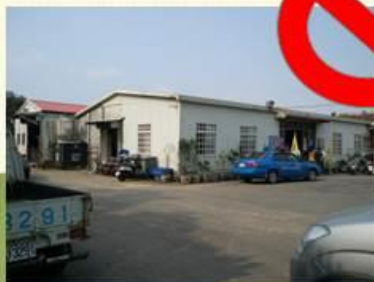
搭建鐵皮建物作工廠、倉庫
