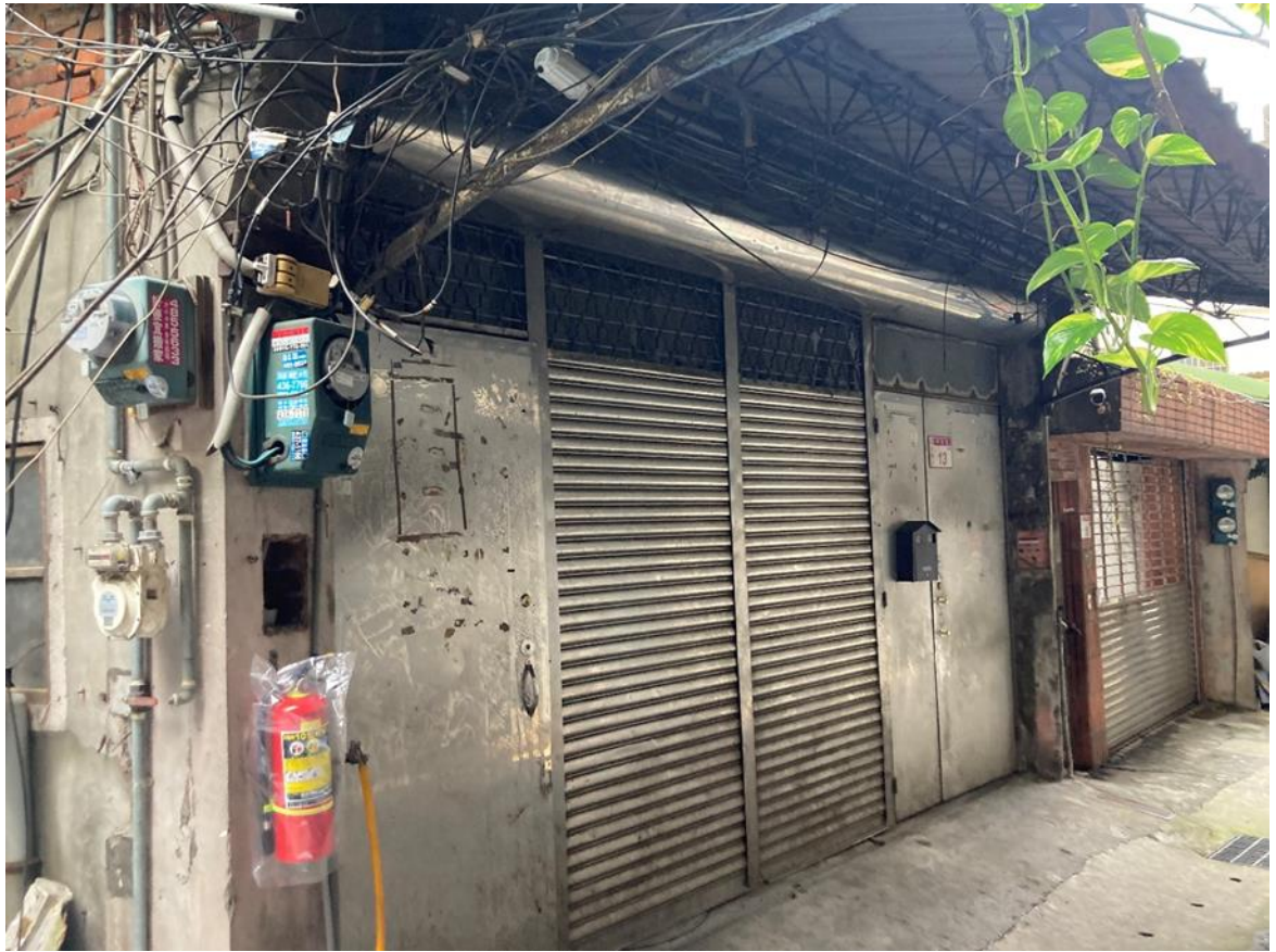
現況照片(桃園市中壢區老街溪段 2386 地號)
