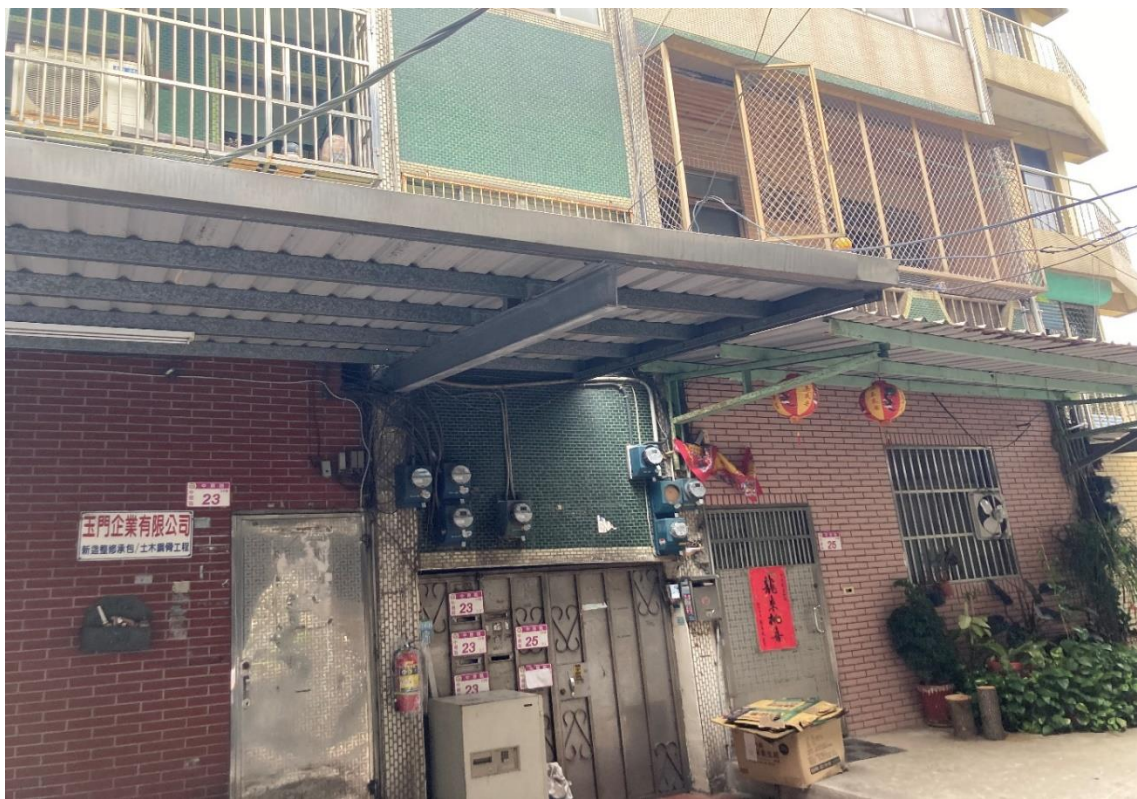
現況照片(桃園市中壢區老街溪段 2384 地號)
