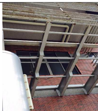
建築物外觀鋁架生鏽
