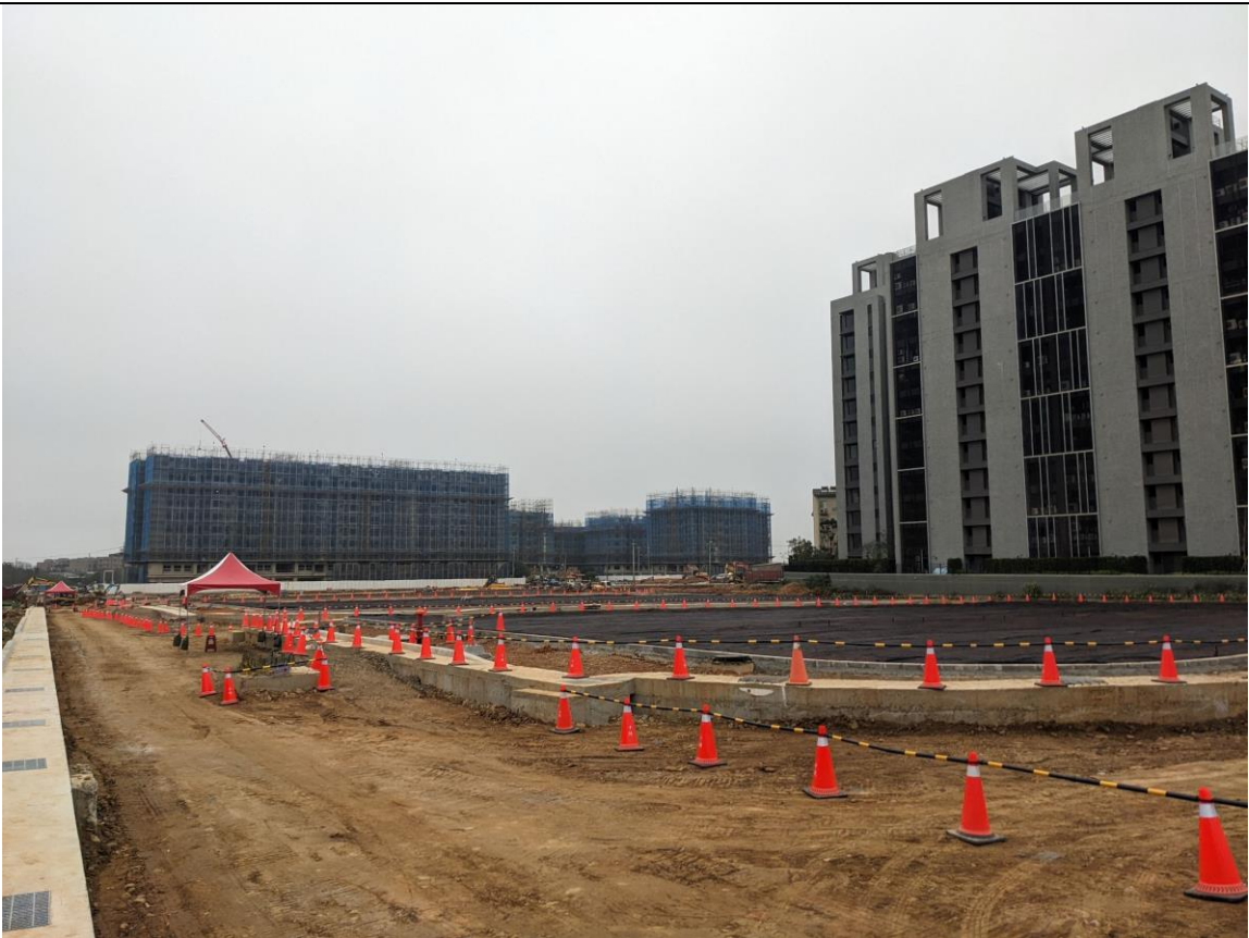
安置街廓施工現況
