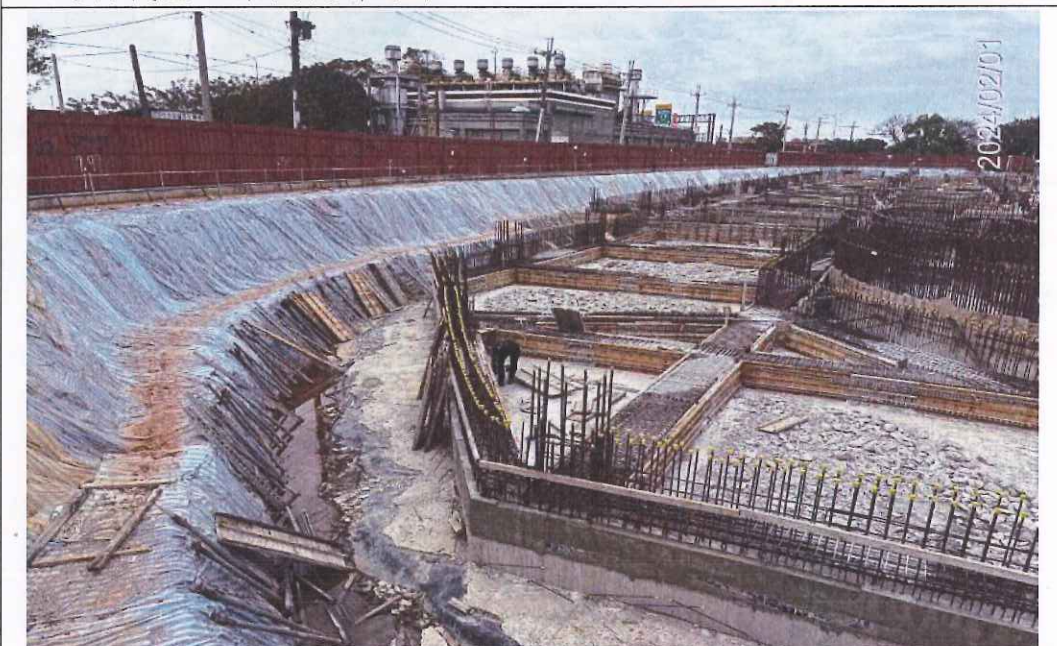
主建物已完成筏基地梁混凝土澆置
