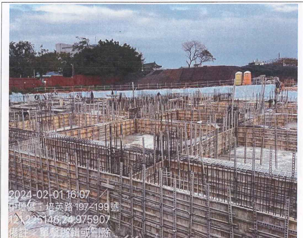
主建物筏基地梁模板拆除中
