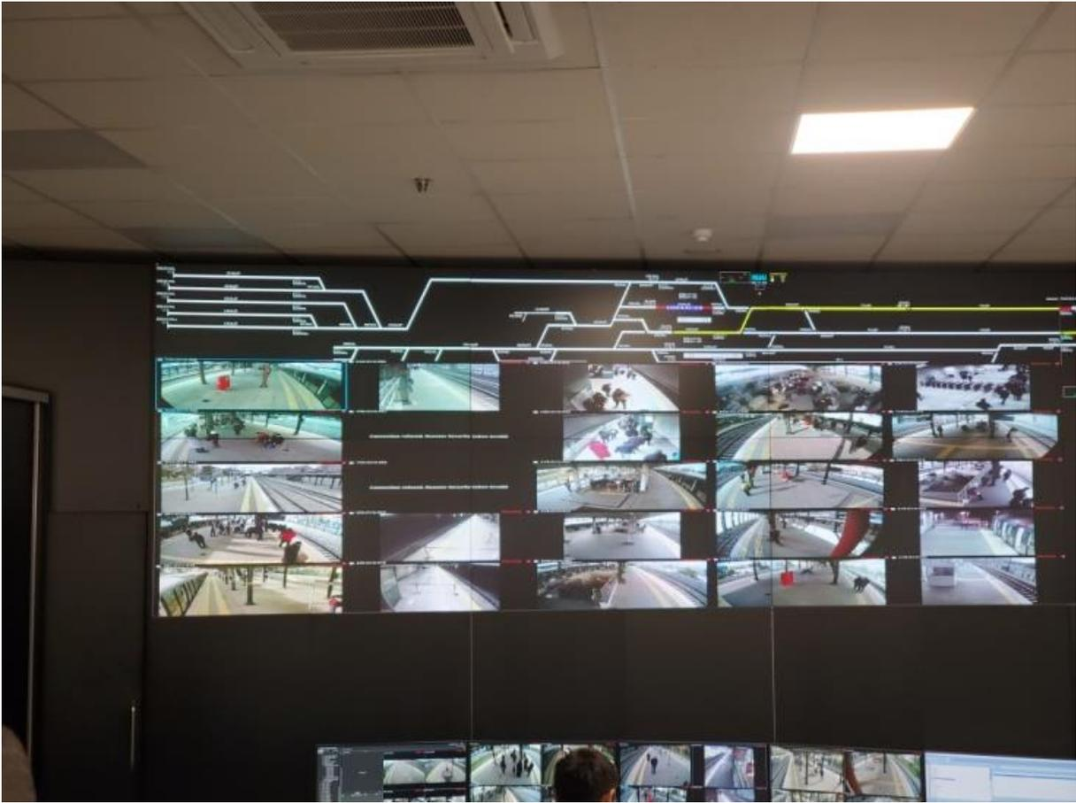
圖 62：馬爾馬拉線行控中心各站之閉路電視(CCTV)
