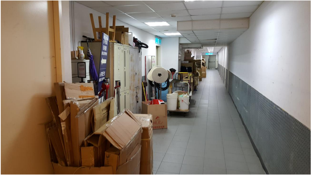
圖三、逃生避難走廊堆置雜物，影響避難安全性
