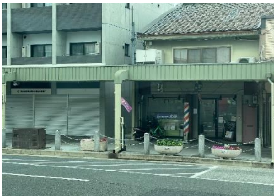
圖 11：排水管統一規劃、製作，視覺上即為整齊清潔
