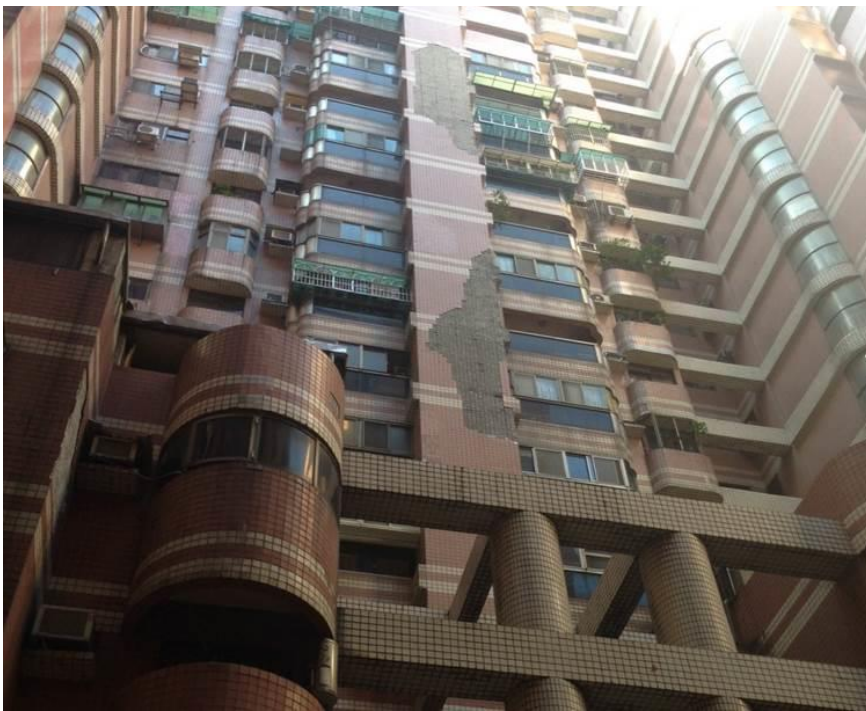
圖一、老舊建物陽臺結構剝落照片
