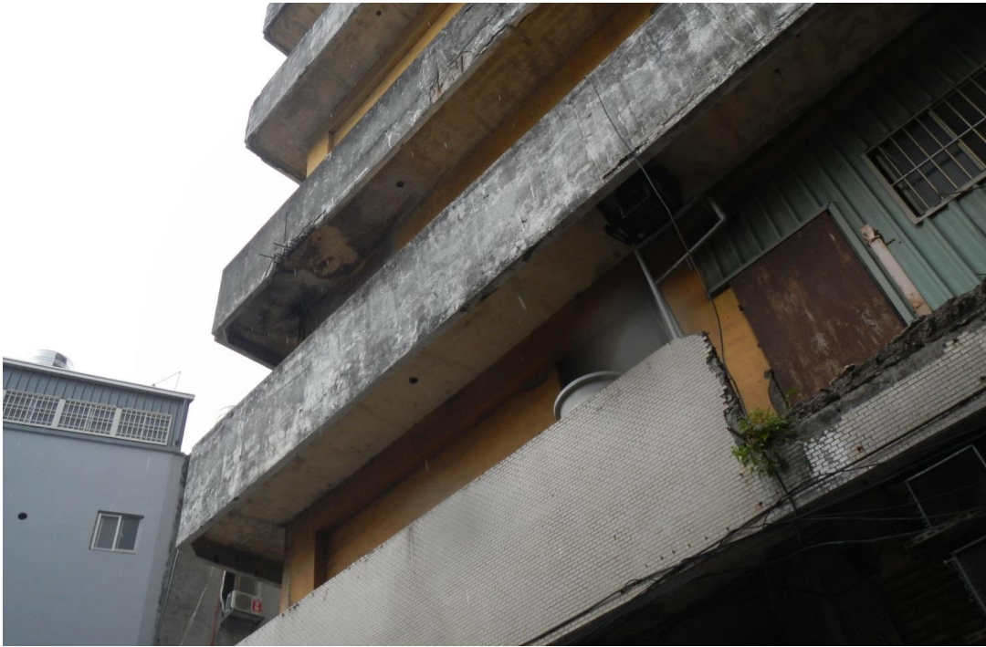
圖一、老舊建物陽臺結構剝落照片
