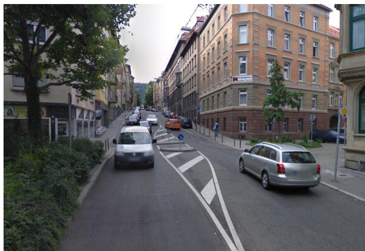
圖 4.15 中央槽化帶設置實例
