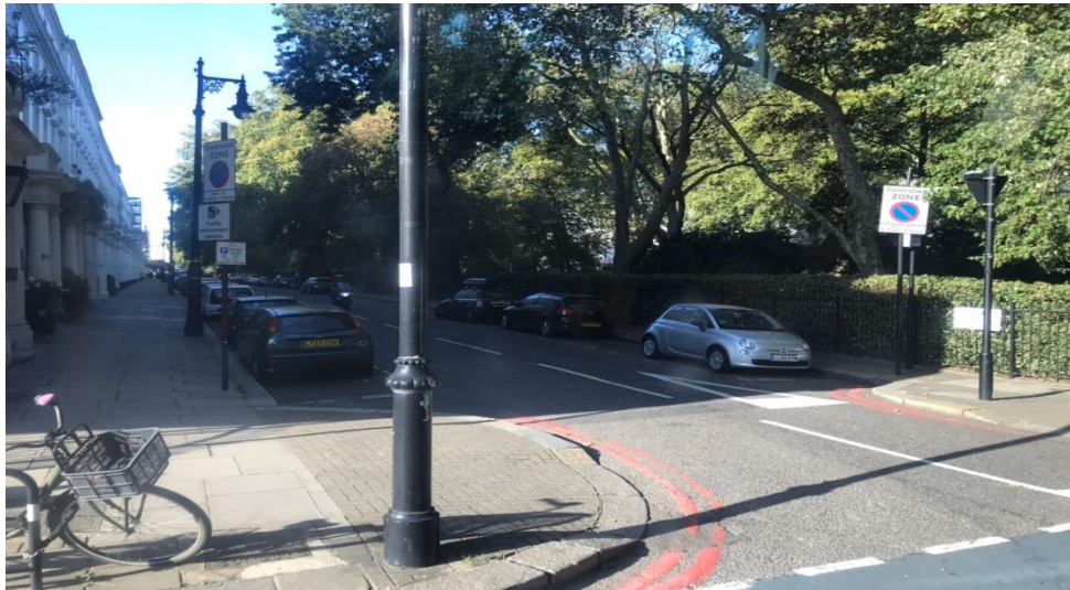
圖 4.21 路口人行道加寬縮減車道設置實例
