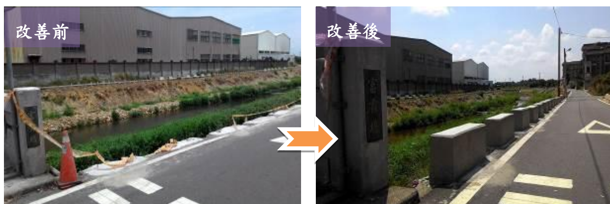
圖 3-34.富林溪堤道護欄修繕
