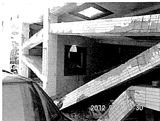
複層式地震倒塌訓練場
