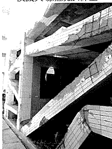
複層式地震倒塌訓練場
