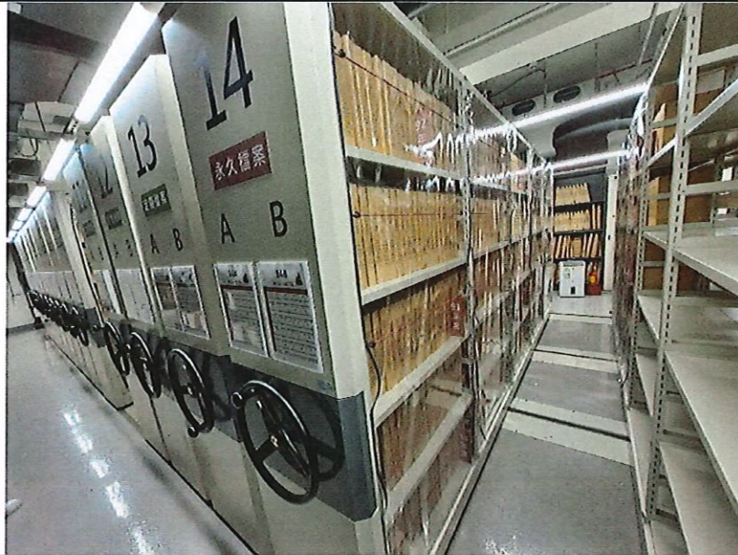
說明：檔案架設置防震繩索及防水捲簾
