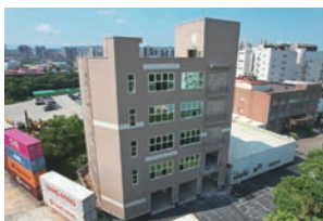
▲ 宏驊新建廠房
