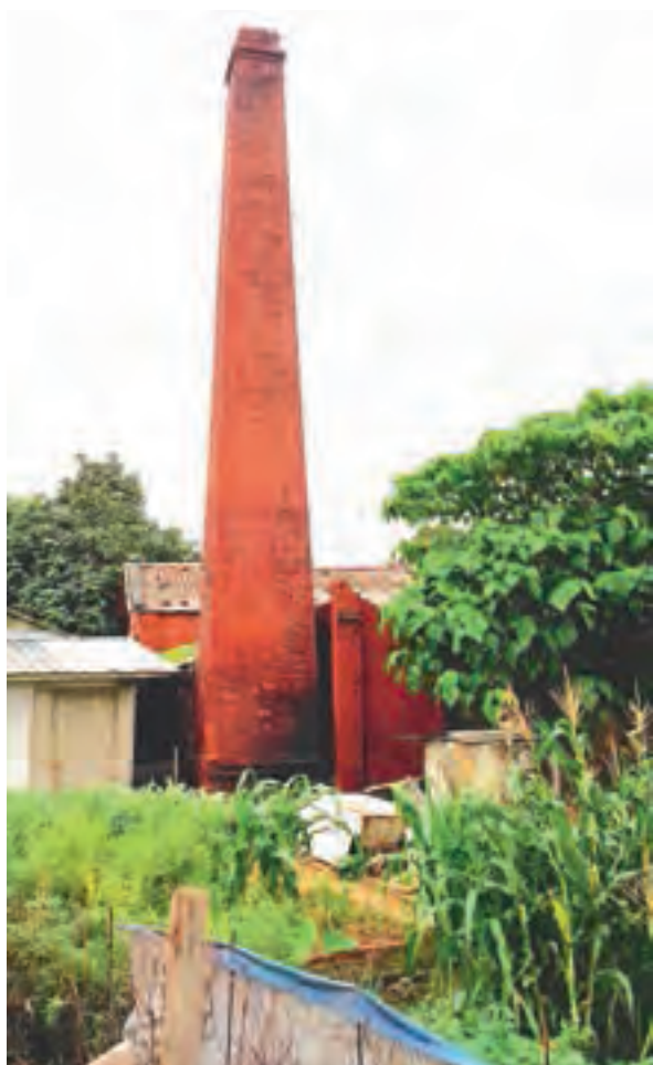
八一四肥皂廠的大煙囪
