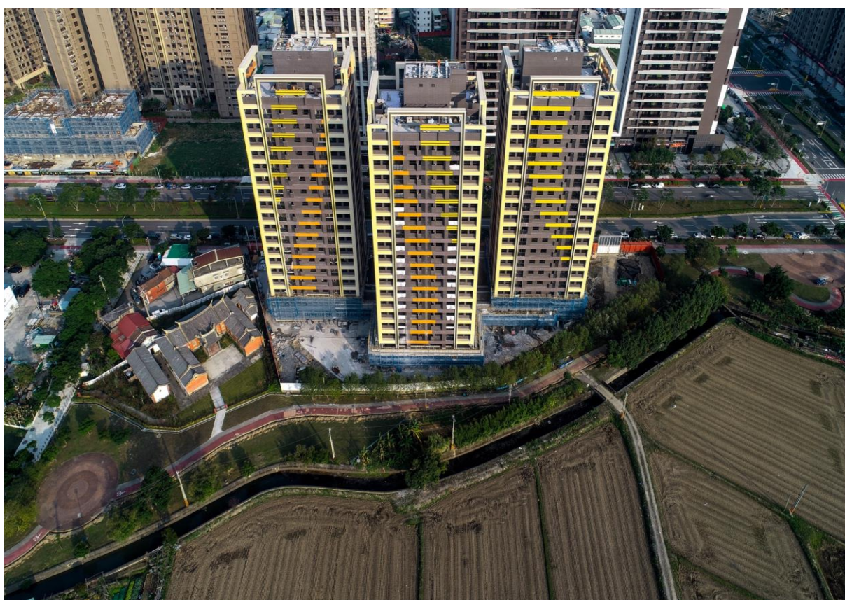
八德一號基地社會住宅施工現況
