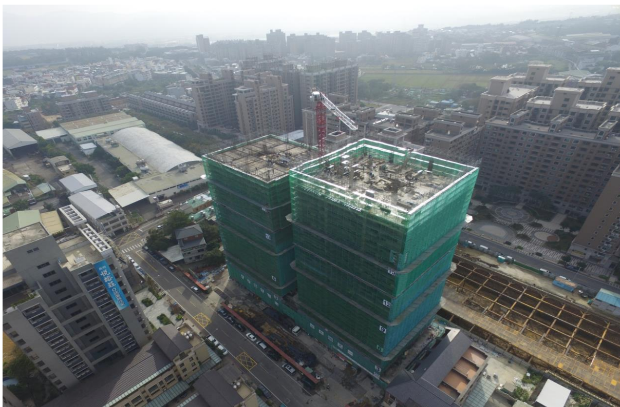
八德二號基地社會住宅施工現況
