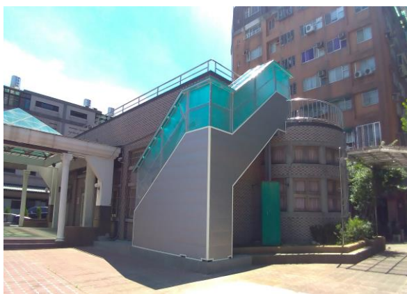
仁和里德和公園兒童遊戲中心增設戶外樓梯 及屋頂護欄工程
