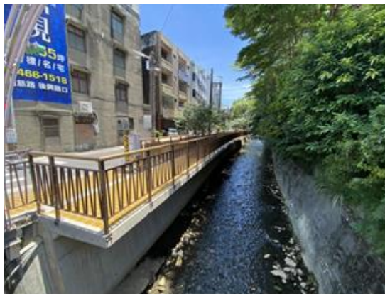
市管區域排水中山東路旁黃屋庄溪上游 護岸復建工程
