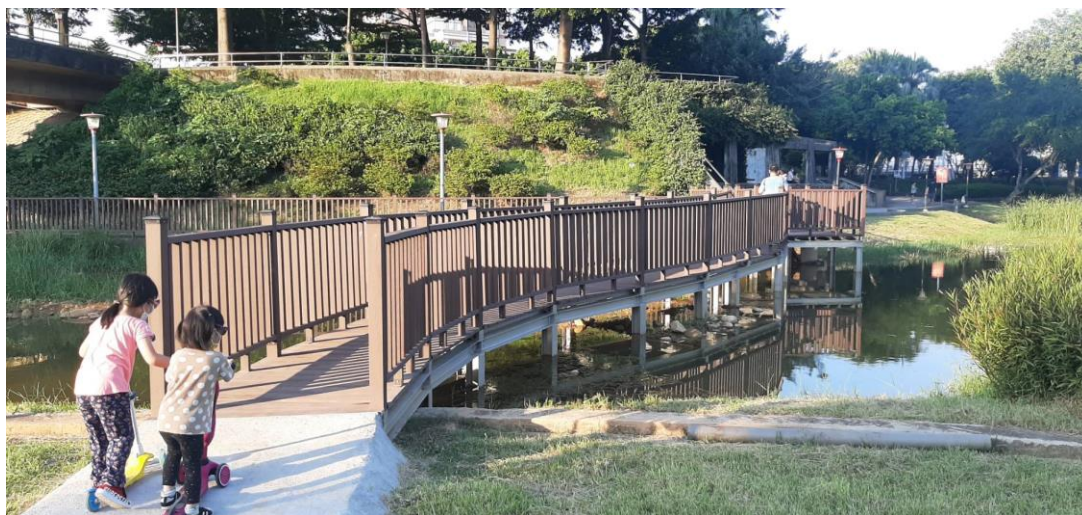
【桃園區陽明木棧道改善工程】
