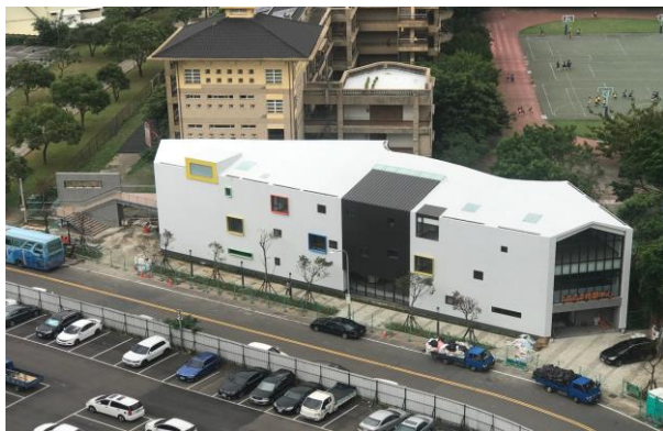
新街金華市民活動中心興建工程
