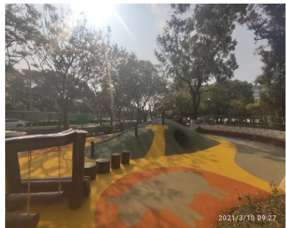
常樂公園共融遊戲場新建工程
