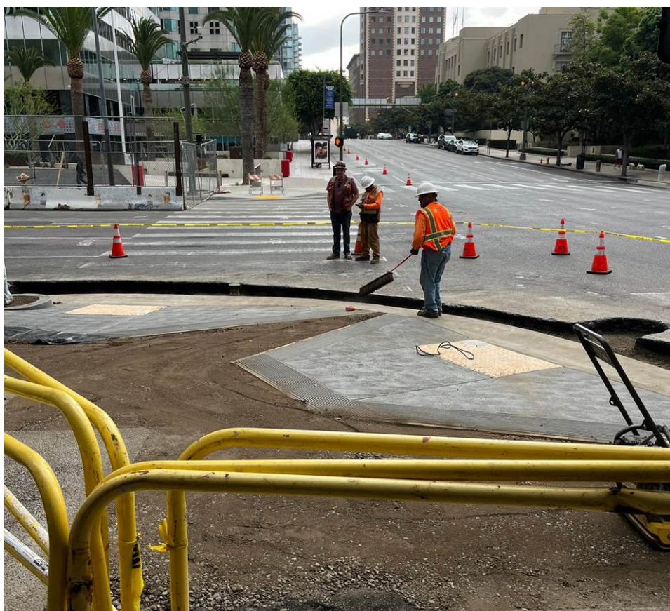
圖 66 人行道施工交通維持設施佈設情形之一(W 5th Street)
