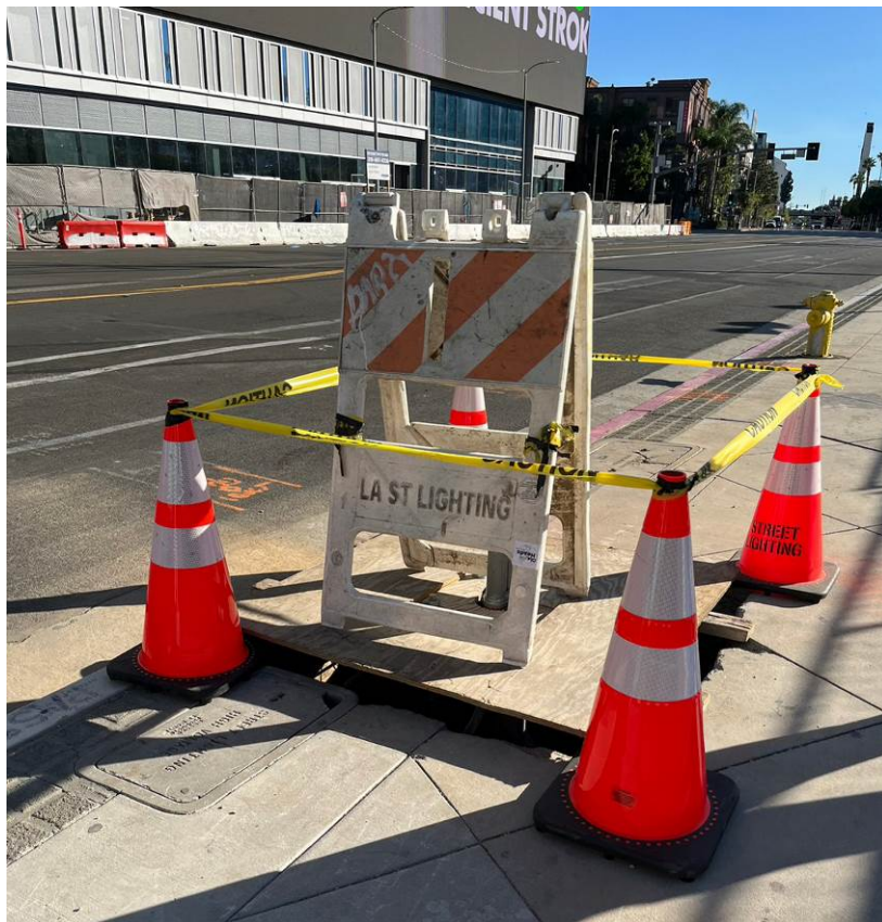
圖 68 人行道施工交通維持設施佈設情形之一(Figueroa Street)
