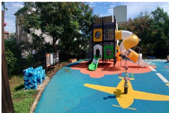
中壢區萬坪公園遊戲場改善工程
