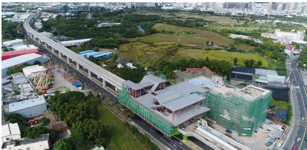
捷運綠線 G13 車站及高架橋梁(115 年第一階段通車路段)
