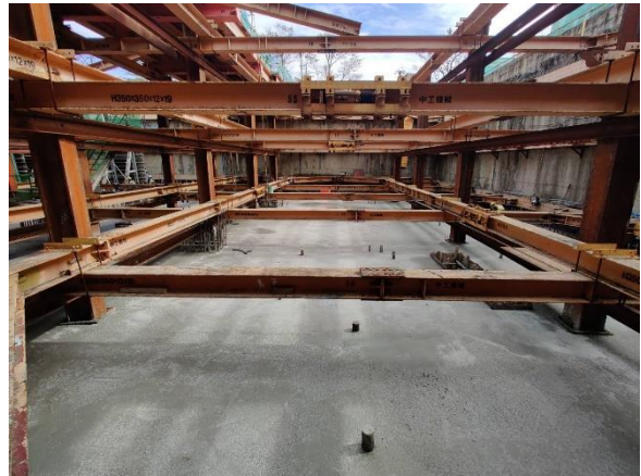
VS6 通風豎井地下一樓版灌漿完成
