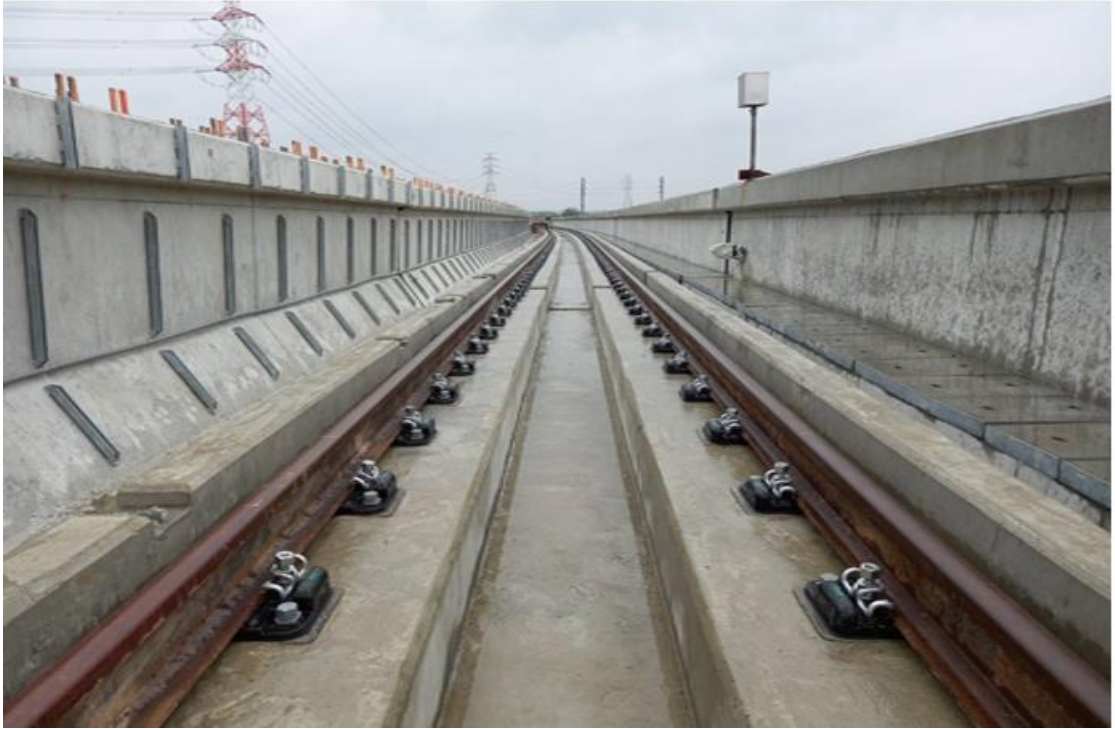
112 年 9 月完成 G13 站至 G13a 站軌道鋪設工程
