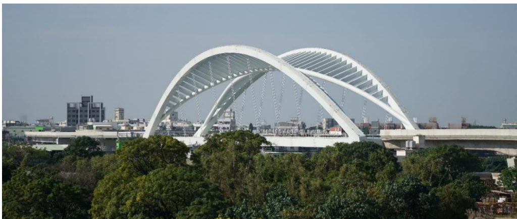
跨南崁溪景觀橋完成
