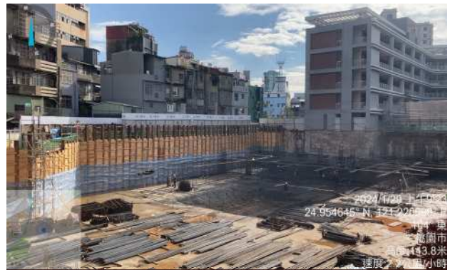
二期施工現況
