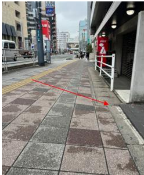
排水溝鋪蓋板及欄杆區隔
