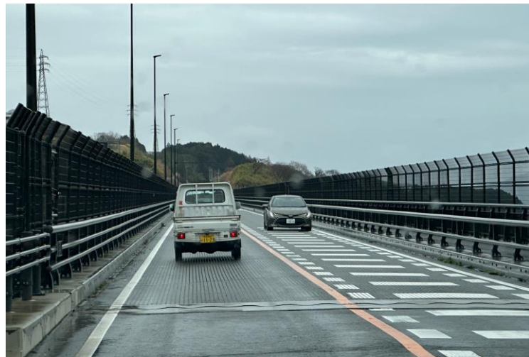
車道楔型減速標線
