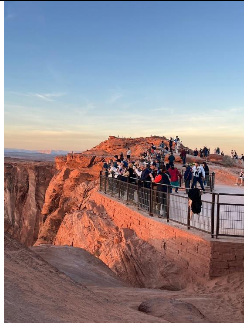
圖 104 馬蹄灣新設觀景台的護欄 (資料來源：團員拍攝)
