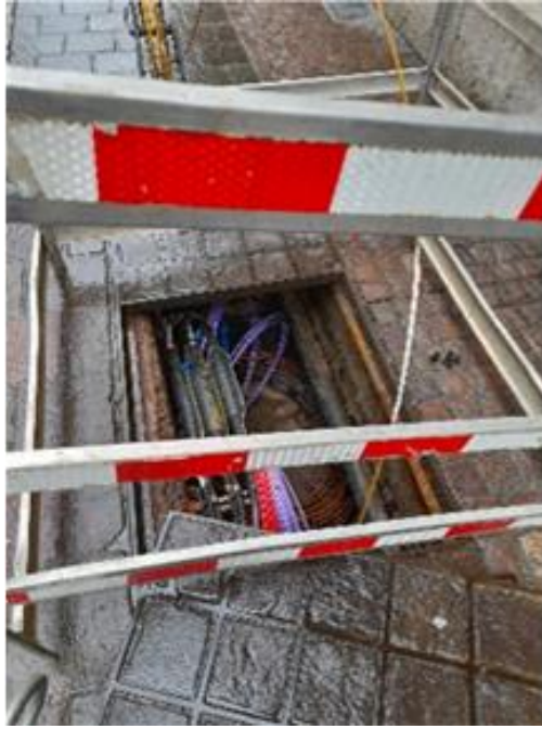
圖23 舊城區排水設施 1
