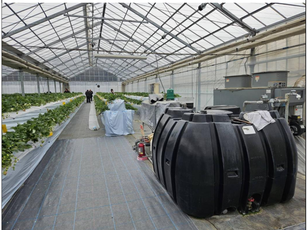
圖26草莓園循環式水養液系統
