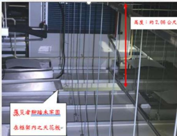
作業人員於3樓碳鋼合金之天花板護蓋上移動時，墜落口之天花板護蓋未牢固在框架內，造成腳踏之天花板護蓋彈開，導致罹災者發生墜落災害。
