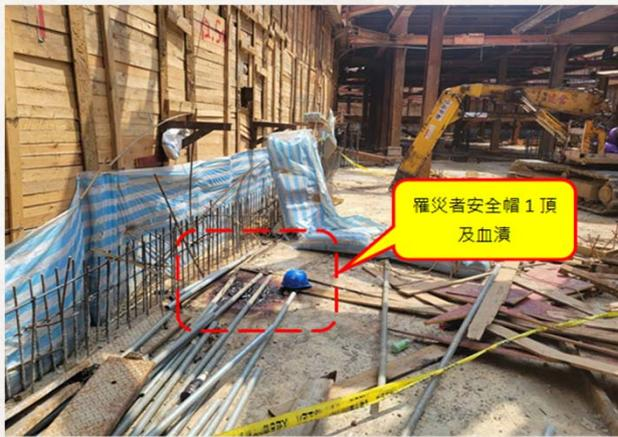
對於拆除作業區，未設置圍柵或標示，禁止非作業人員進入拆除範圍內及構造物有飛落、震落之虞者，未優先拆除，致發生工作者遭混凝土塊飛落致死職業災害。
