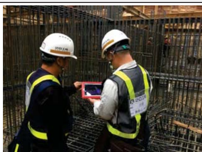
現場施作確認
