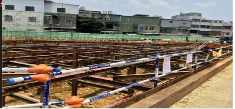
107年05月15日主體棟土方開挖支撐架施作
