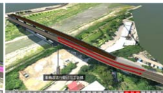
◆ 車輛改道行駛下游側已完工新橋
