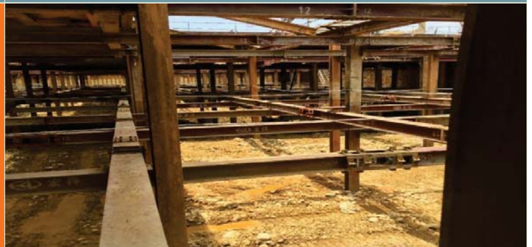
107年05月15日主體棟土方開挖支撐架施作
