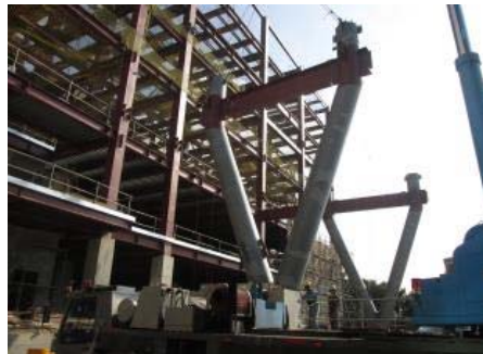
V型柱施工吊裝
