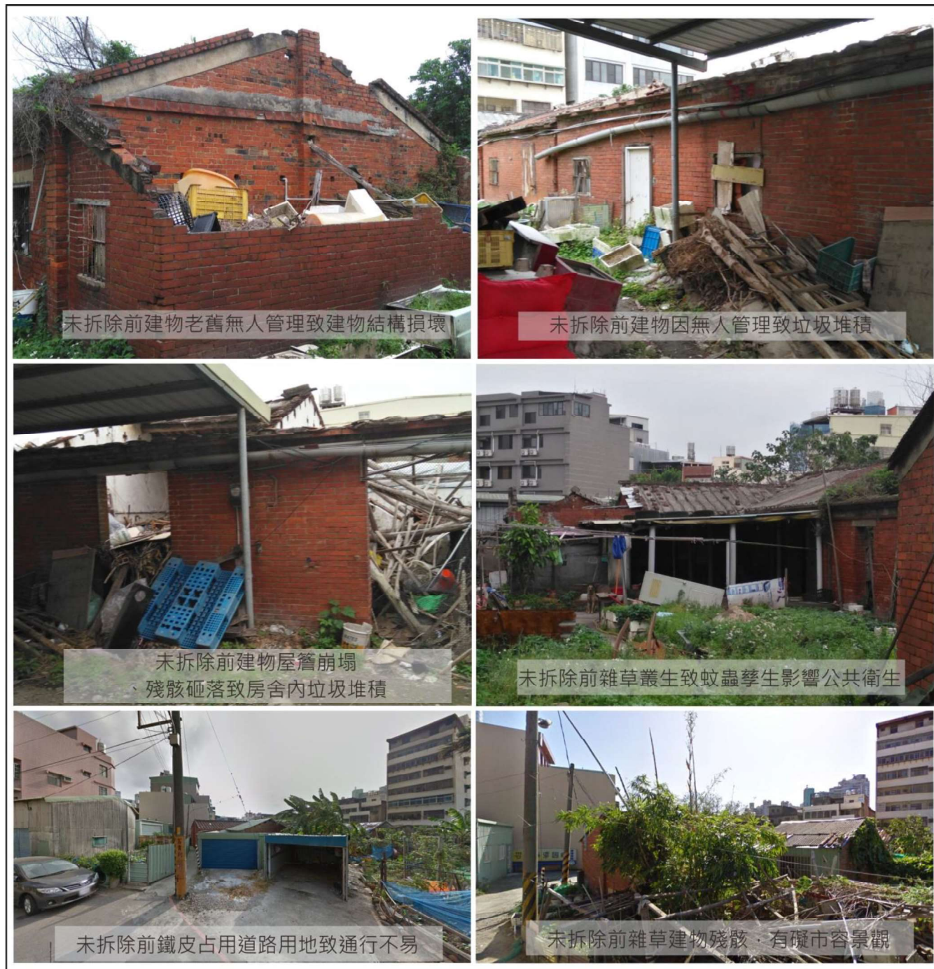
圖 3 計畫範圍內拆除前廠陋房舍實況圖
