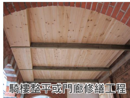
騎樓整平或門廊修繕工程
