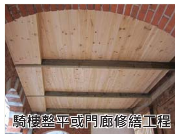
騎樓整平或門廊修繕工程
