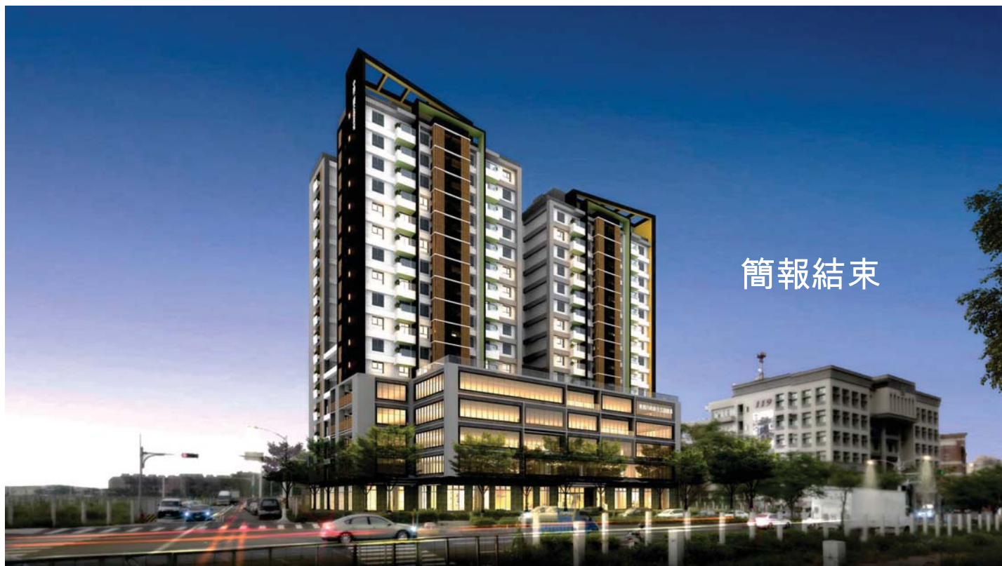
桃園市桃園區中路二號基地新建公營住宅統包工程
