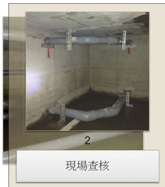
筏基填土區BIM模型與實際排水管施作比對
