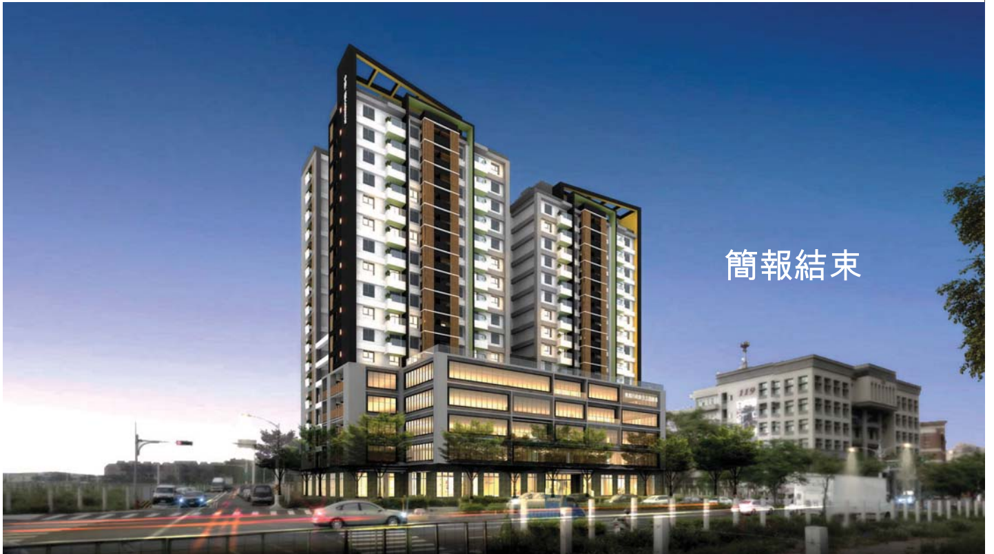
桃園市桃園區中路二號基地新建公營住宅統包工程
