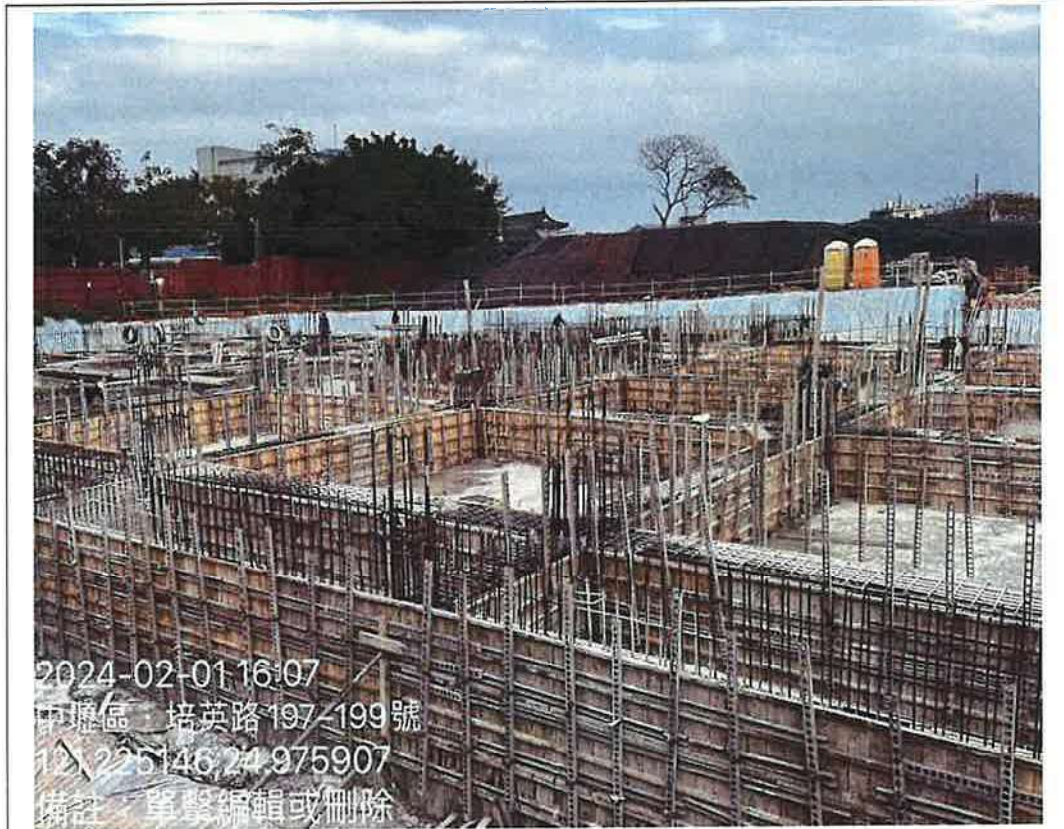
主建物筏基地梁模板拆除中
