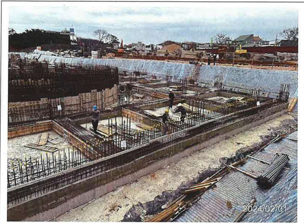
主建物已完成筏基地梁混凝土澆置
