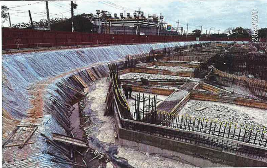
主建物已完成筏基地梁混凝土澆置
