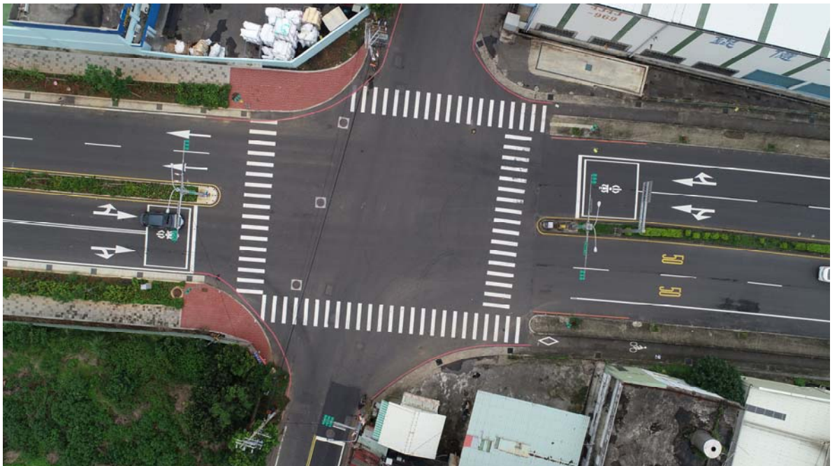
圖 1.2-2 工程起點現況俯視照片
