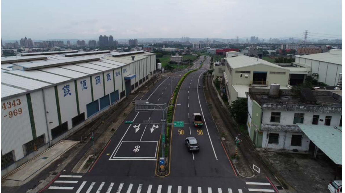
圖 1.2-1 工程起點現況空拍照
