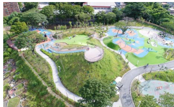
中和區員山公園旁第六公墓遷移後新闢公園工程
