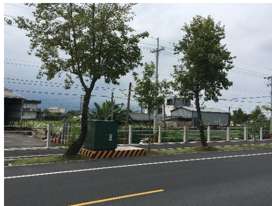
宜 18-2 線 6k+800-7k+880 道路改善工程
