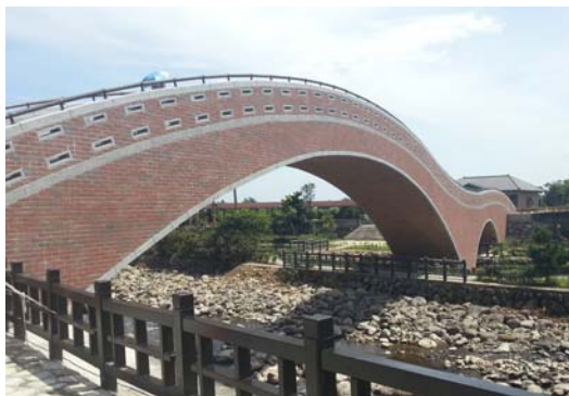
新北市三芝區根德大橋改建工程(日景)
