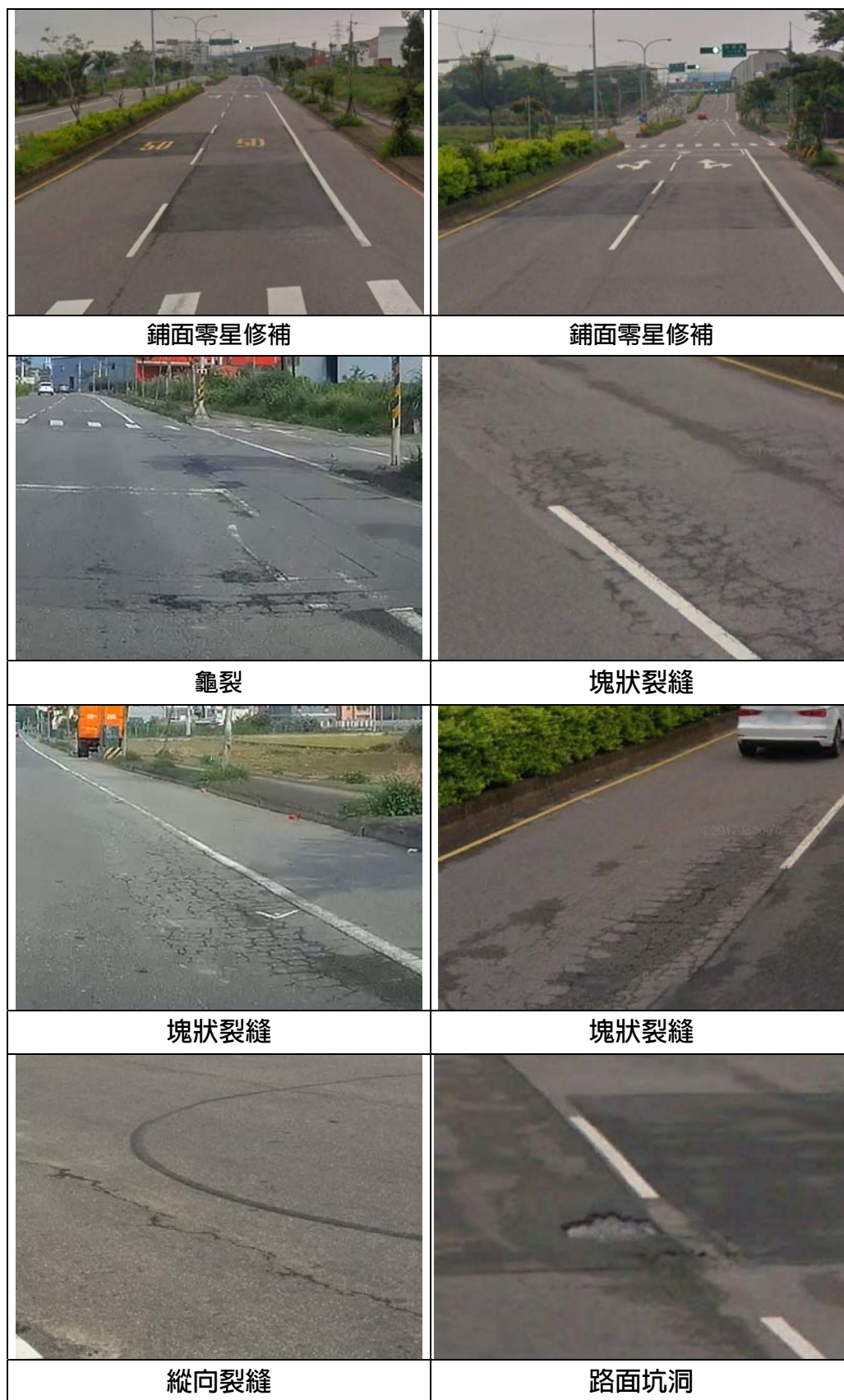
圖 2.2-2 計畫道路現況鋪面品質照片
