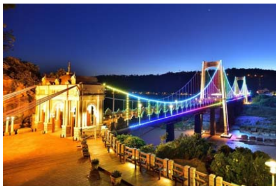
桃園市大溪區大溪橋第二期整修工程
