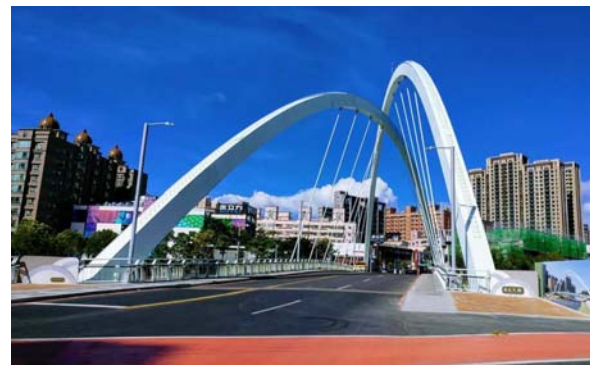
桃園市蘆竹區忠孝西橋改建工程
