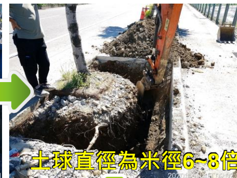
斷根前樹穴旁RC打除
