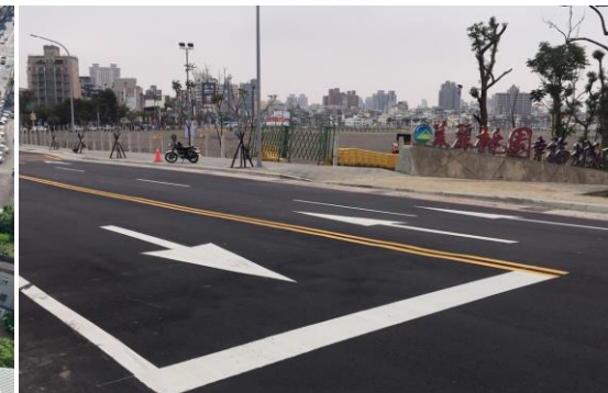
桃園區三元街道路拓寬工程
