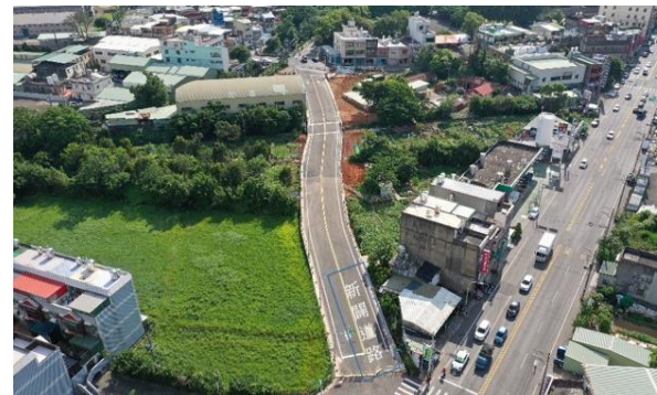
觀音區忠富路(桃85號)彎道改善工程
