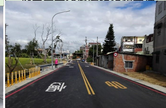
平鎮區華安街道路新闢工程
