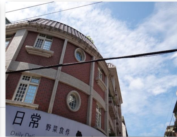
圖1-2.大溪區民權東路清整後
