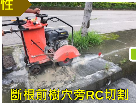
斷根前樹穴旁RC打除
