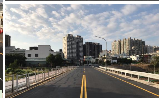
桃園區益壽八街道路拓寬工程
