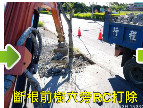
斷根前樹穴旁RC切割
