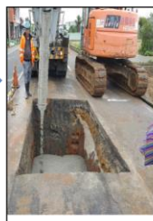
管溝回填(再利用)
