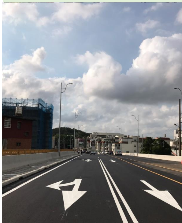
楊梅區五楊高架橋校前路交流道道路拓寬工程
