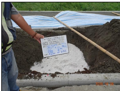
底層鋪設排水材料
