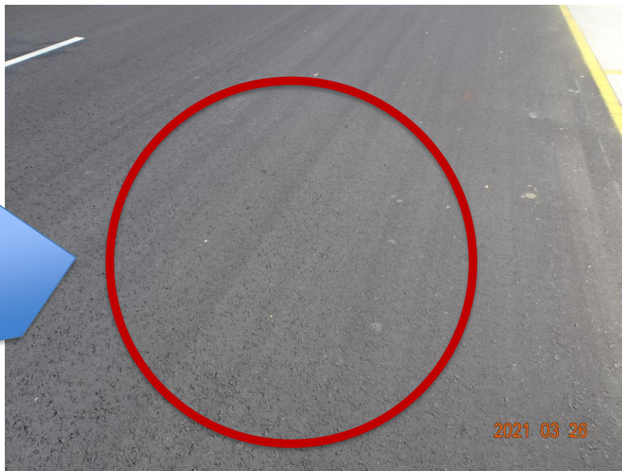
本案1in(25mm)鋪設後完成面
