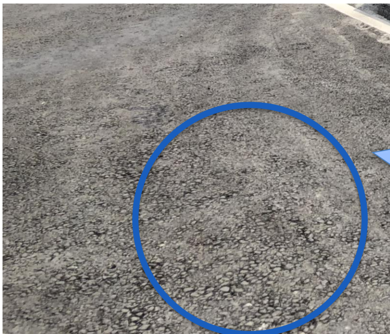
一般1in(25mm)鋪設後完成面
