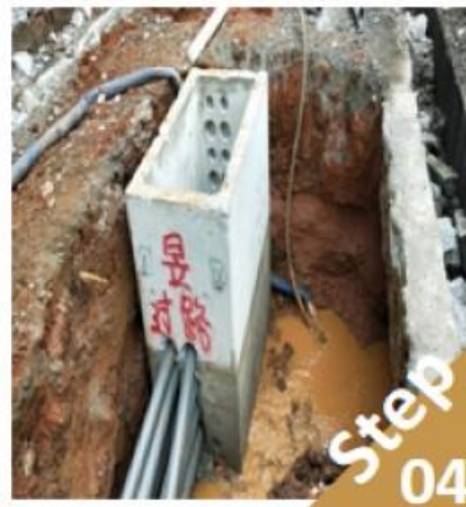
預鑄人孔埋設
