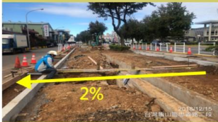
設施拆除高差調整
