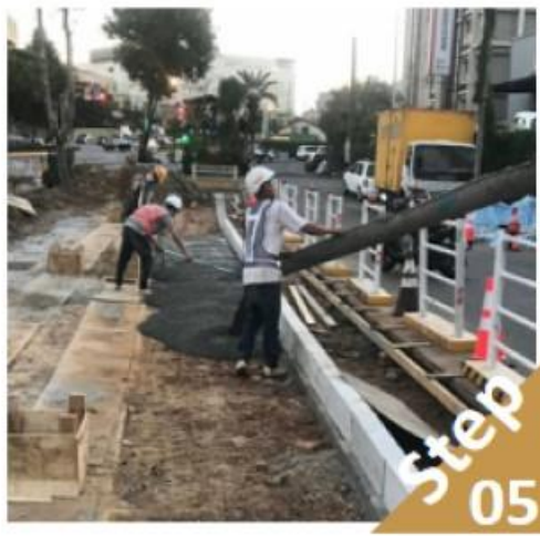
混凝土回填
