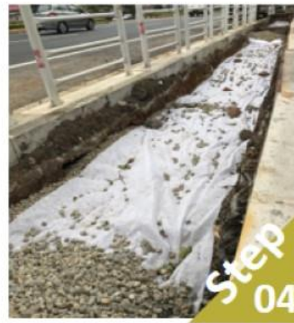
濾層鋪築完畢
