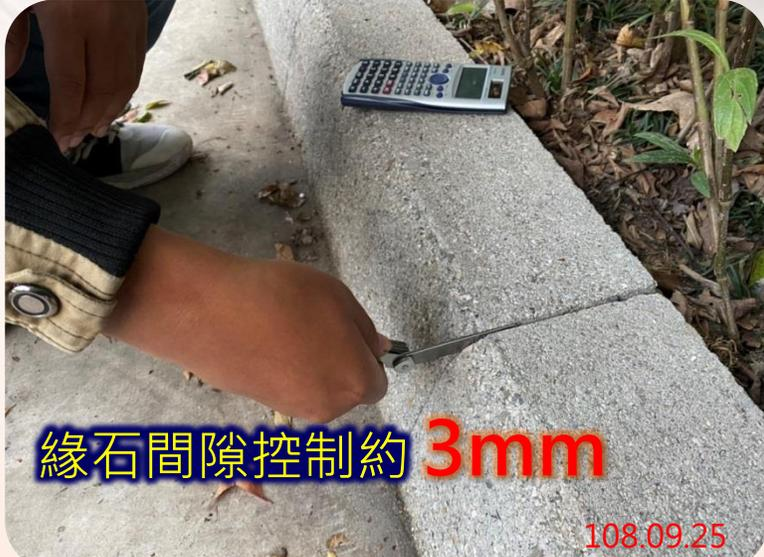
緣石間隙控制約 **3mm**
