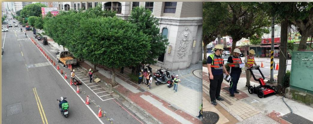
透地雷達地下管線探測
