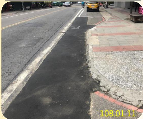
龜裂、塌陷、反射裂縫
