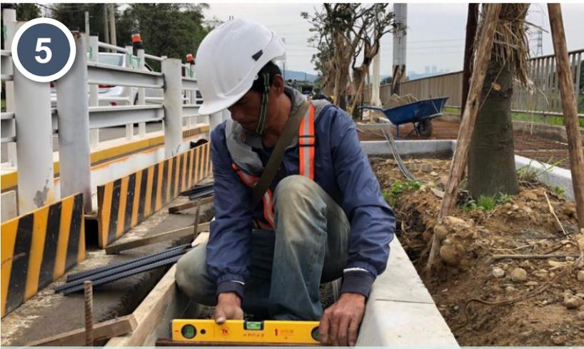
5 邊溝/緣石支撐材水平性檢核
