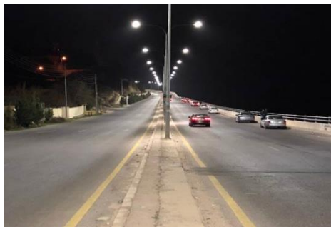
照度型LED路燈於雨天視野產生斑馬效應 (路面亮暗對比明顯-濕潤W1路面)
