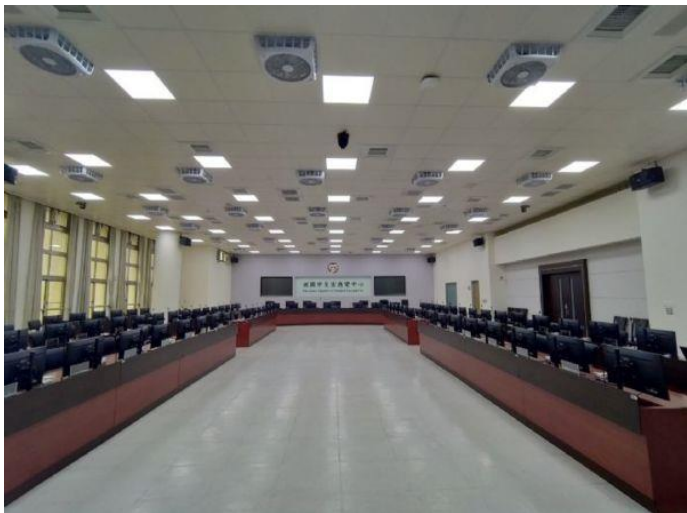
桃園市政府消防局大樓照明節能改善 (2020屋內照明設施類優等獎)
