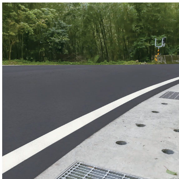
透水路面與排水溝讓路面不積水
