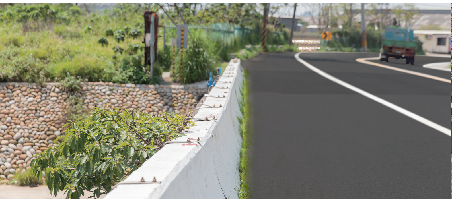
茄荖溪橋護欄改善
