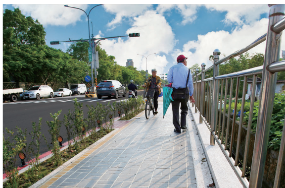
加設護欄的人行道
