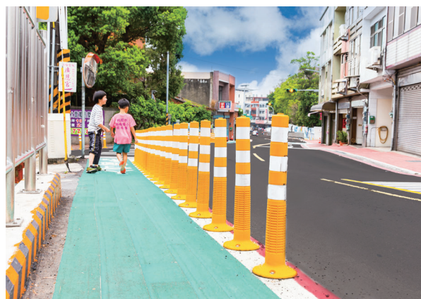
新設標線型人行道鋪設
