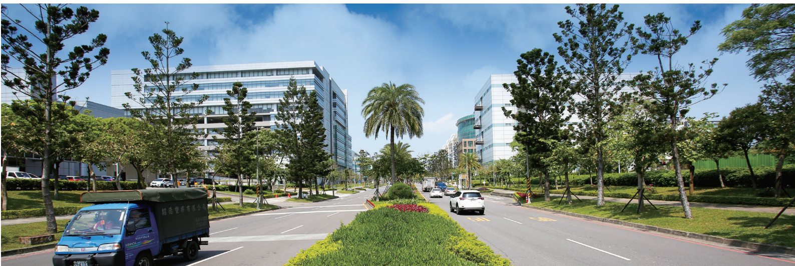
焚化底渣磚鋪設的柏油路平又直
