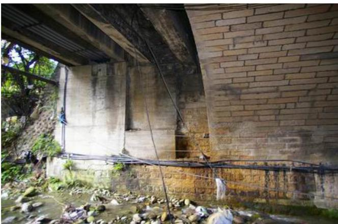
圖 10：「大坑溪橋」拓寬後之東側橋底現況，由南下車道底部橋臺處可清楚看到歷次修建之過程。（李盛沐提供）
