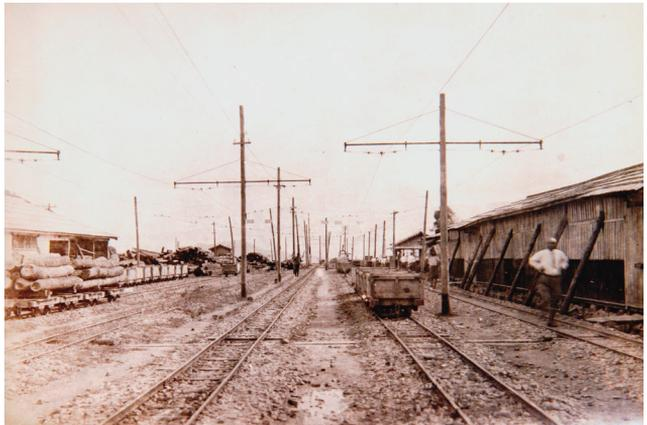
圖 6：日月潭水力發電的電車與電線。透過這張照片可以看到遠方的電車架著一集電弓，以跟上方的電線聯通。
